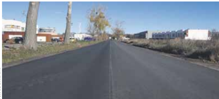
Nawierzchnia ul. Poznańskiej w Dąbrówce po remoncie prezentuje się imponująco
