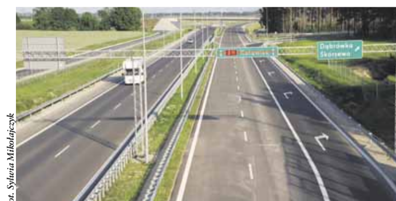
Najnowsza droga szybkiego ruchu S11 na terenie Gminy Dopiewo. Widok z wiaduktu w Zakrzewie
