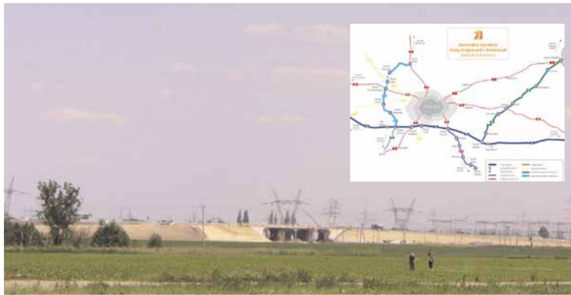
Węzeł w Dąbrowce jeszcze w czasie budowy
