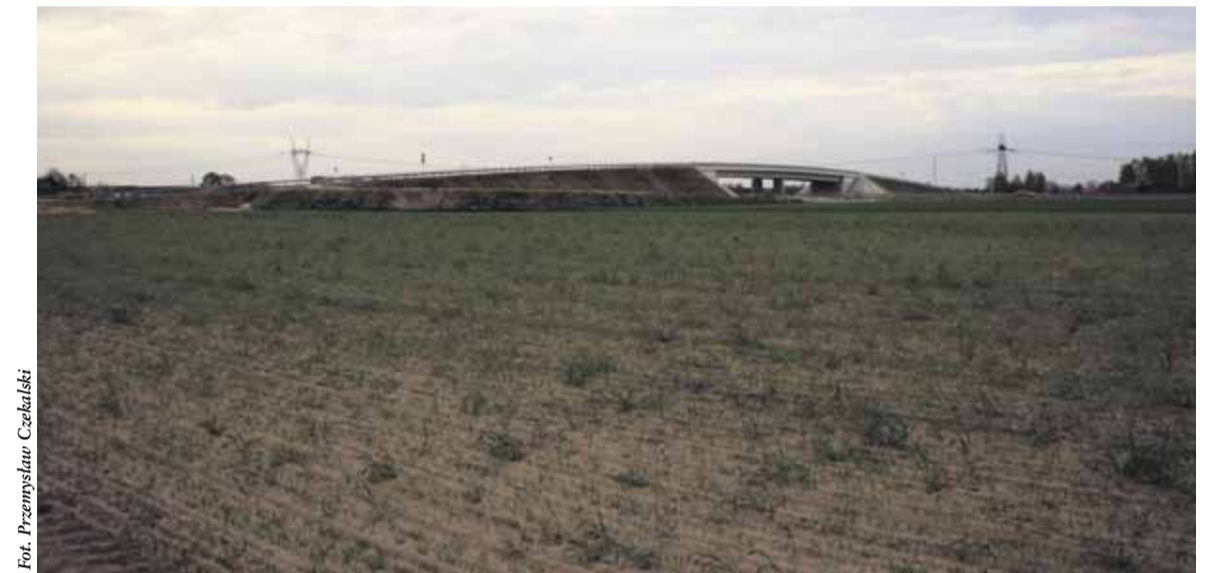
Tereny inwestycyjne przy drodze S11, od strony Zakrzewa
